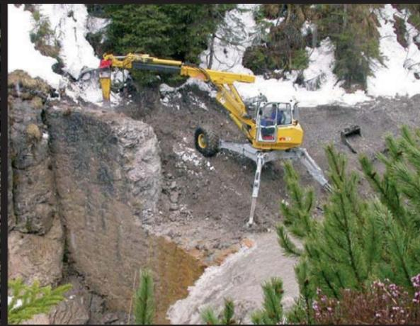
Hornbach 2003 und 2005, Sperrenabtragung in 2 Stufen
